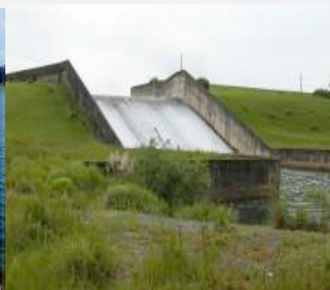
Represa do Pasaúna Barragem do Vertedouro – 2014
