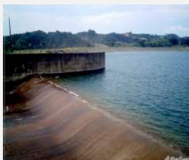
Represa do Passaúna Base do Vertedouro – 2014
