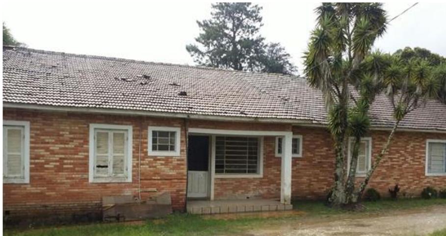
FIGURA 16 – ESTRUTURA QUE FOI SEDE DA ESCOLA ATÉ FIM DE 2011
