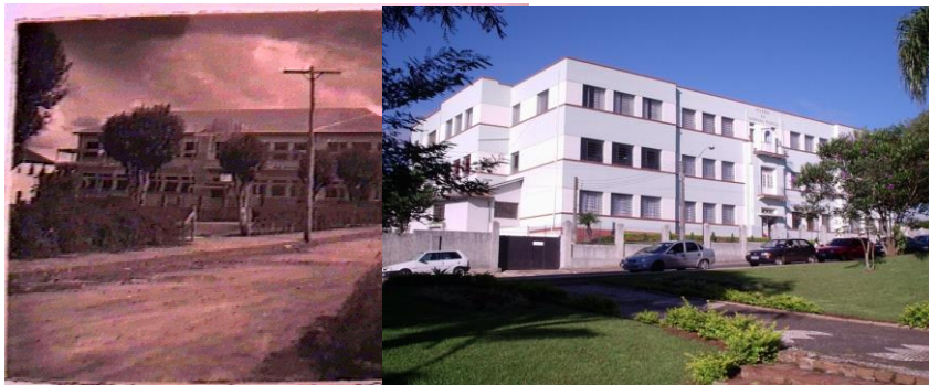
Figuras 5 e 6 – O prédio atual
