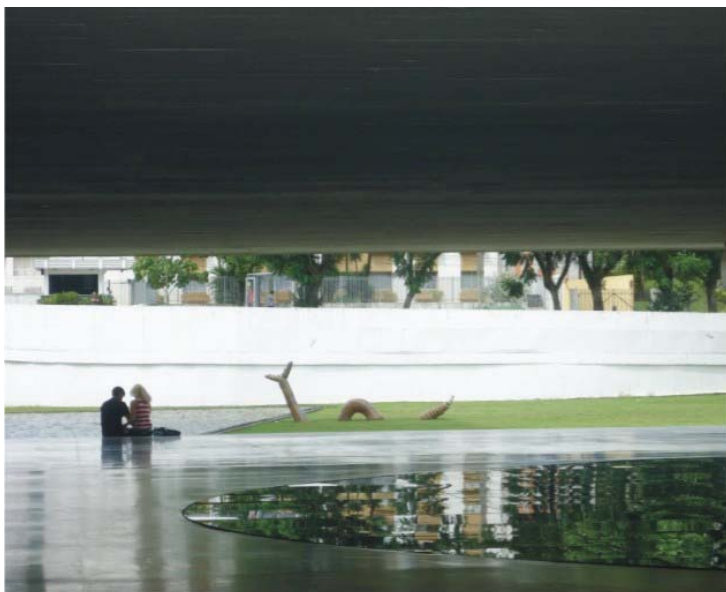
FIGURA 26 - MUSEU OSCAR NIEMEYER COMO PRAÇA PÚBLICA, SEM GUARDA-CORPO FONTE: A autora., 26 mar. 2011
