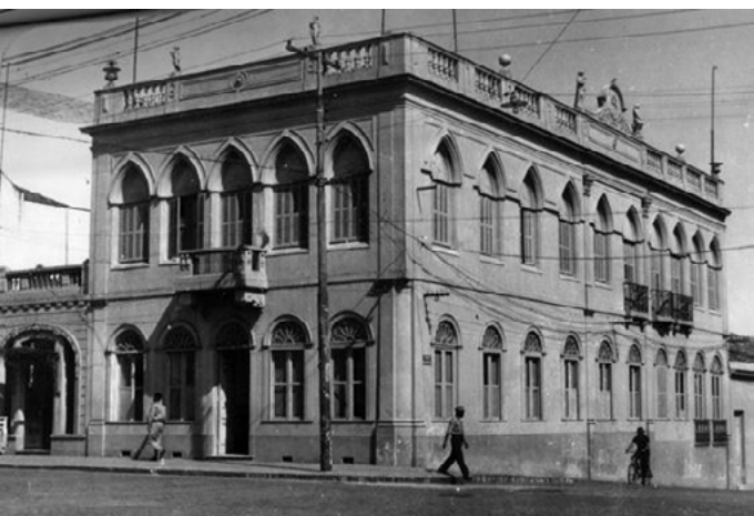
Fig. 1 – Imóvel doado a Escola de Belas Artes (EBA) por Carmen Trápaga Simões, em 1963. Fonte: Coleção EBA/Fototeca Memória da UFPel.
